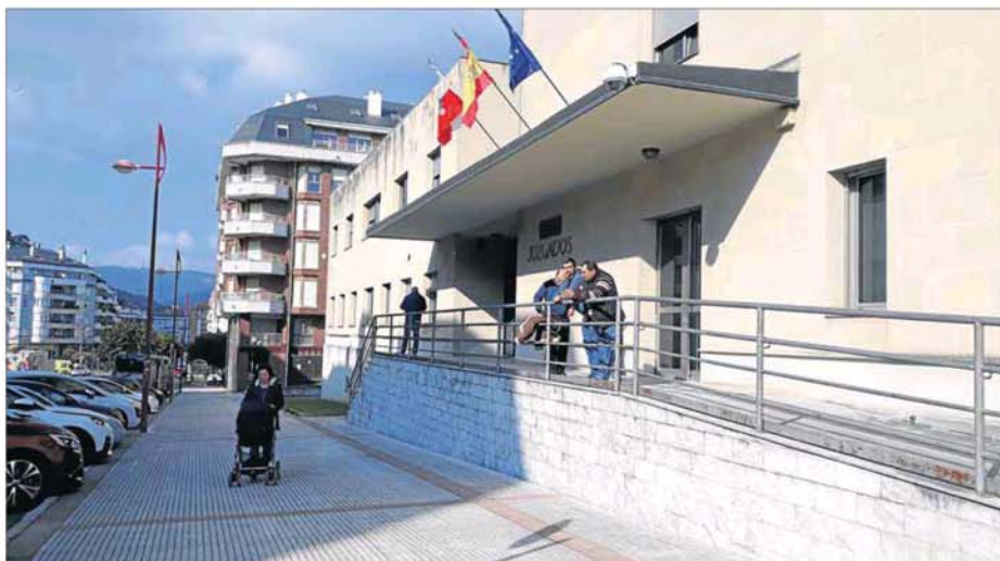
El SOJ se ubicará en el edificio de los Juzgados, en el número 8 de la calle Nicolás Torre. :: S. HIDALGO
